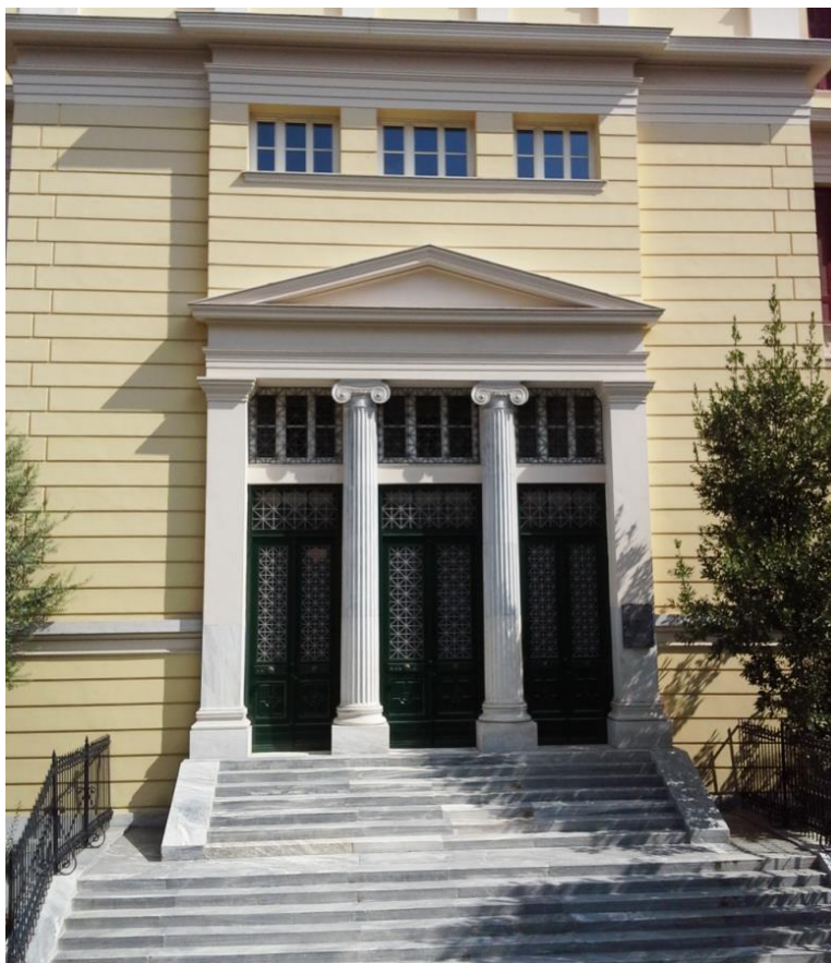
Εικόνα 1: Το κτήριο του Φυσικείου / Παλαιού Χημείου
