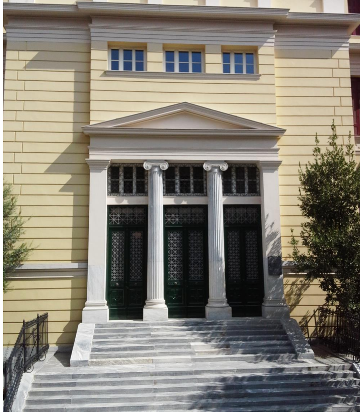
Φωτογραφία της Εισόδου του Κτηρίου, μετά την ανακαίνισή του.
